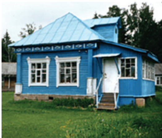
Здание лаборатории 1905 г. постройки.
